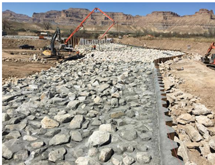
ภาพ 24 เชื่อนป้องกันตลิ่งแบบเรียงหินยาว (Grouted Riprap)
