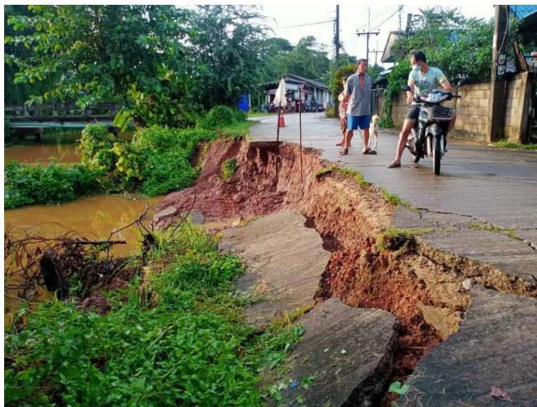
ภาพ 1 การวิบัติพังทลายของลาดดินตลิ่งลำน้ำ บ้านป่าตึงใต้ หมู่ที่ 6 ตำบลแม่ใจ อำเภอแม่ใจ จังหวัดพะเยา
