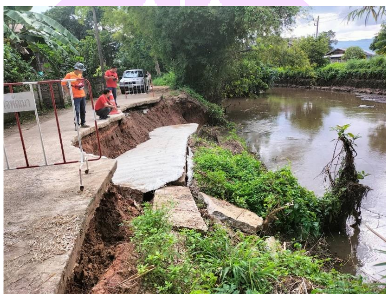
ภาพ 7 การพังทลายของลาดดินตลิ่งลำน้ำ บ้านป่าตึงเหนือ หมู่ที่ 8 ตำบลแม่ใจ อำเภอแม่ใจ จังหวัดพะเยา
