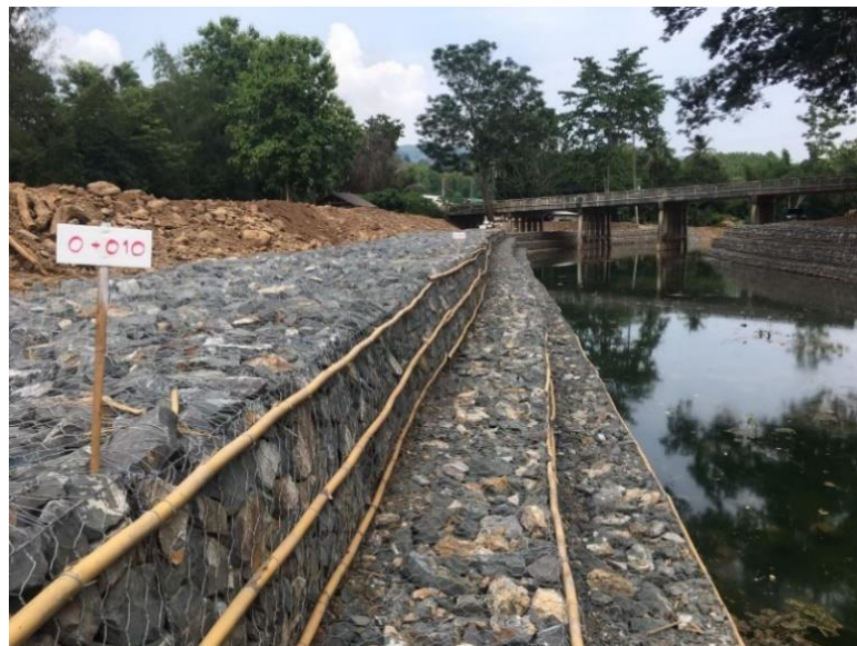
ภาพ 23 การเรียงกล่องบรรจุหิน (Gabion)
