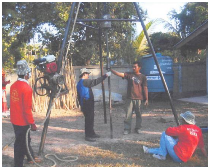
ภาพ 6 การเจาะสำรวจดินโครงการก่อสร้างระบบประปาหมู่บ้าน หมู่ที่ 6 บ้านป่าตึงใต้
