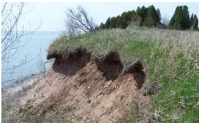
ภาพ 18 Collapse of layer undercut by piping/sapping
