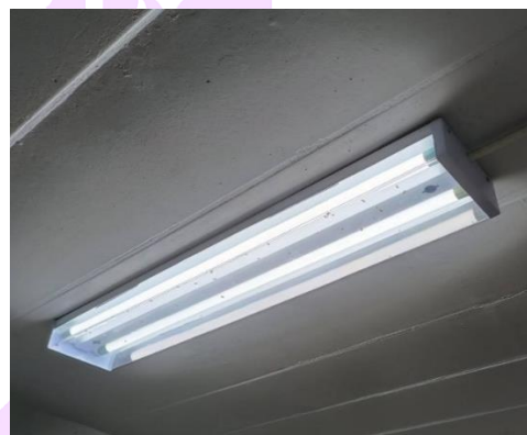
ภาพ 27 หลอดไฟฟ้า LED ขนาด 18 วัตต์ (ก) หลอดไฟฟ้า LED ที่ไปเปลี่ยนหลอดไฟฟ้า เดิม (ข)
