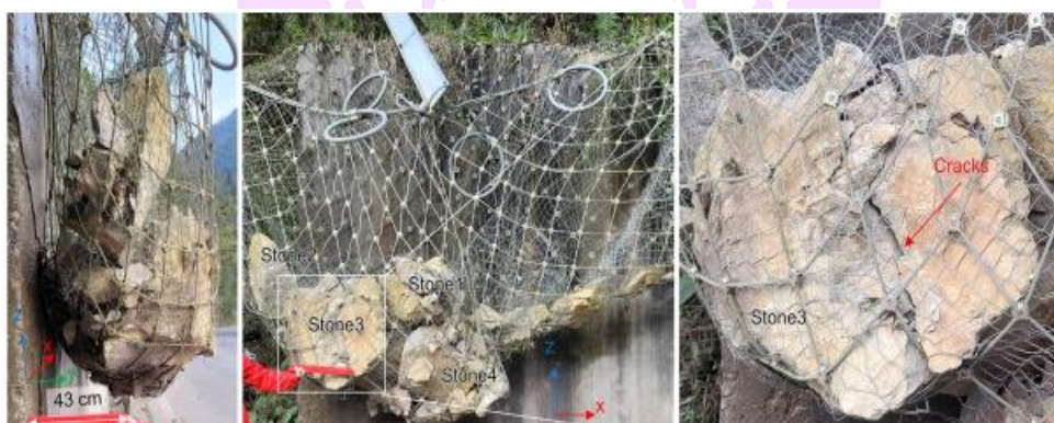
ภาพ 5 การใช้โครงสร้างแบบยัดหินในพื้นที่จริงเพื่อป้องกันความเสียหายจากหินถล่ม
