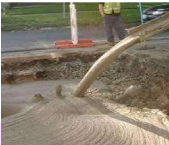
ภาพ 5 แสดงการใช้ CLSM เป็นวัสดุเทขึ้นพื้นทางในรัฐอิลลินอยส์ (www.irmca.org)
