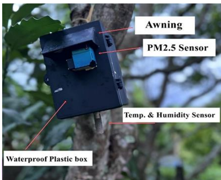
ภาพ 33 อุปกรณ์ตรวจจับไฟไหม้ที่ถูกติดตั้งบนต้นไม้ ในสถานที่จริง
